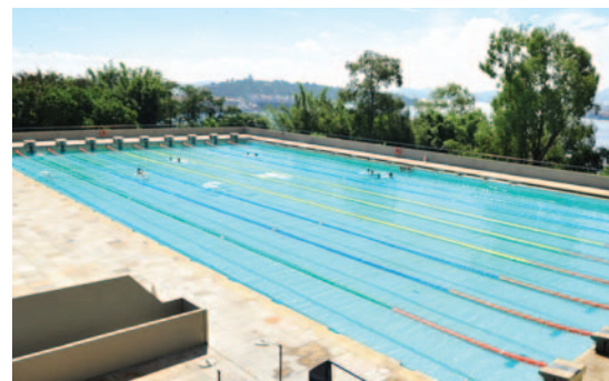
Piscina Olímpica da Base Naval do Rio de Janeiro
