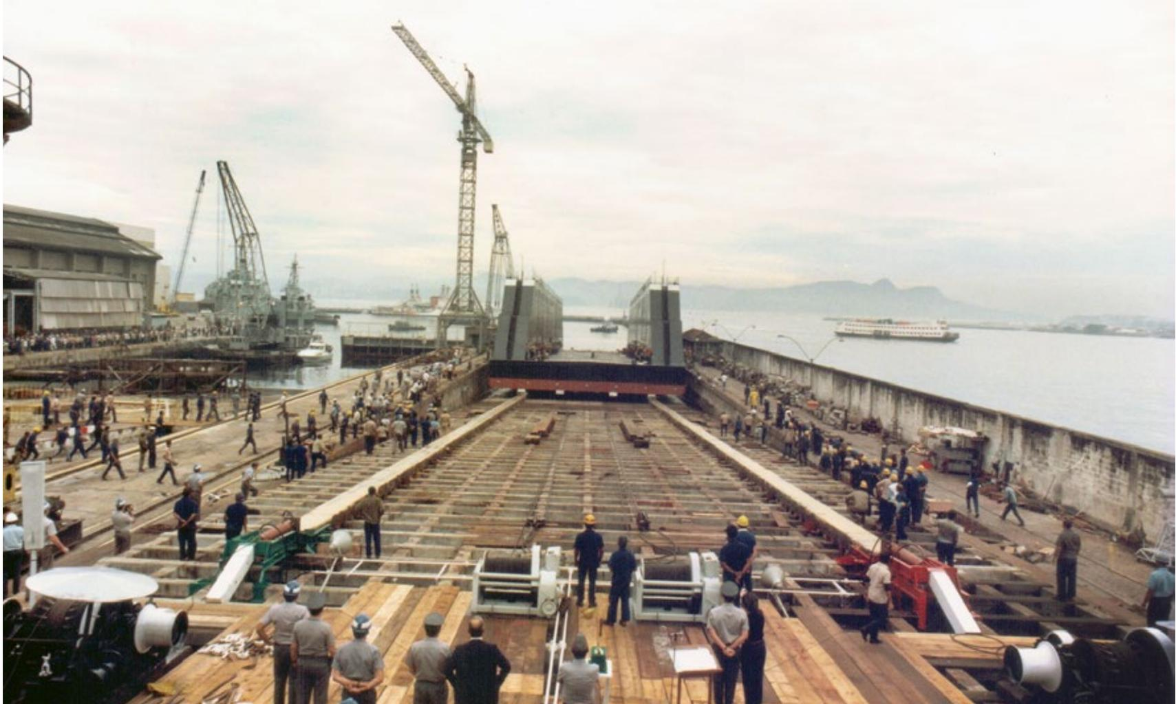
Utilizado amplamente na construção e no reparo de navios e submarinos no Arsenal de Marinha, durante um período de dois anos, o Dique Flutuante “Almirante Schieck”, de 1.500 t de deslocamento, passou por importantes reparos estruturais na Carreira II do Arsenal, onde havia sido construído 23 anos antes.
