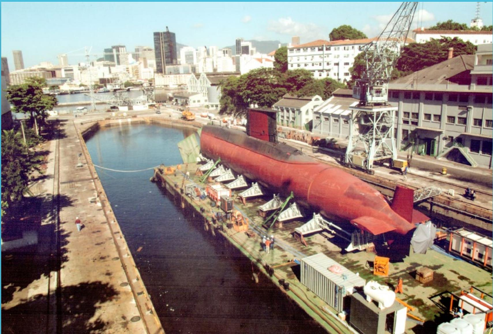
Após estudo técnico concluir pela exequibilidade do transporte do Submarino “Timbira” para o interior do Edifício 17 do Arsenal de Marinha, para a execução do seu Período de Manutenção Geral, foi desenvolvido um projeto técnico que
