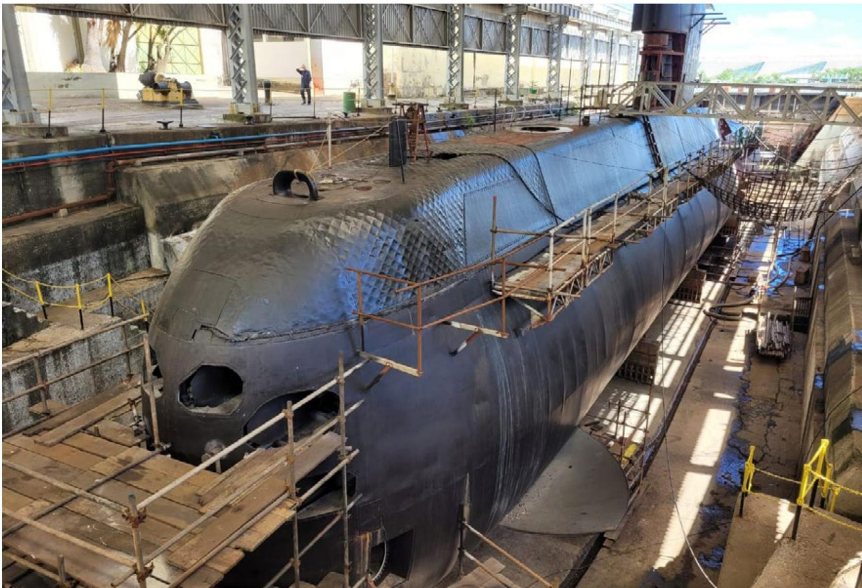
De forma a manter nossos navios e submarinos operativos e prontos para defender nossos mares e rios, períodos regulares de manutenção são necessários. Uma etapa vital da manutenção são os Períodos de Manutenção Geral, nos quais a embarcação passa por ampla revisão de seus sistemas e equipamentos. Exemplo desse trabalho foi o período de manutenção do Submarino “Tikuna”.
